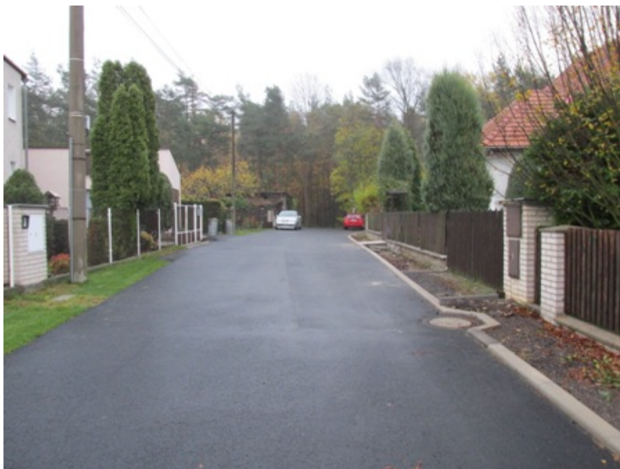
Opravené místní komunikace
